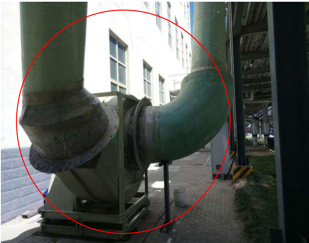
增压风机安装后
