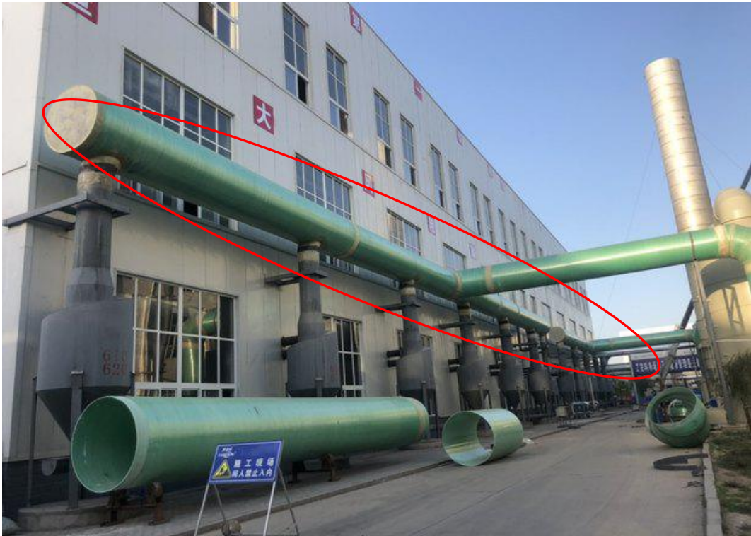
103 车间南侧整改后
