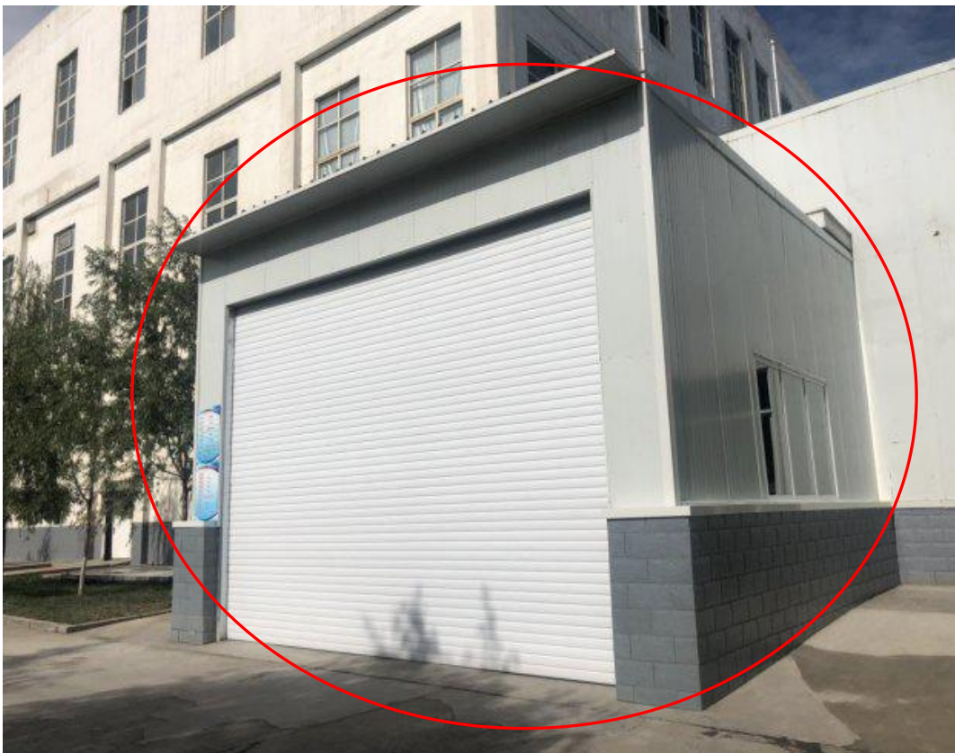
缓冲间建设后
