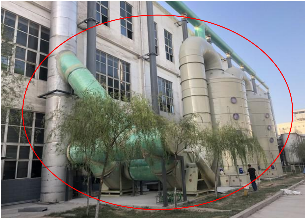
102 车间南侧整改后
