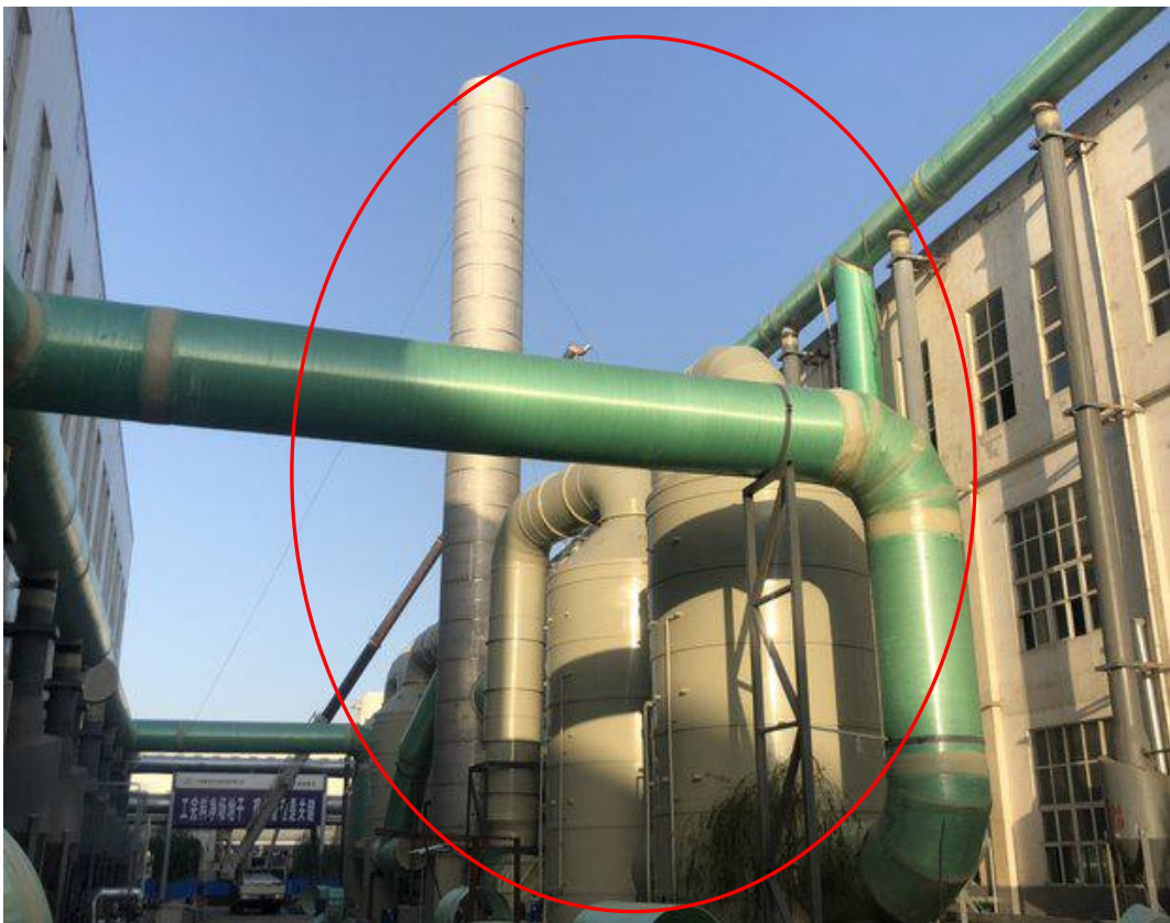
102 车间北侧整改后
