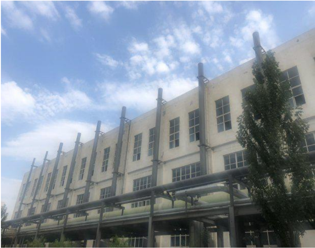
101 车间北侧整改前
