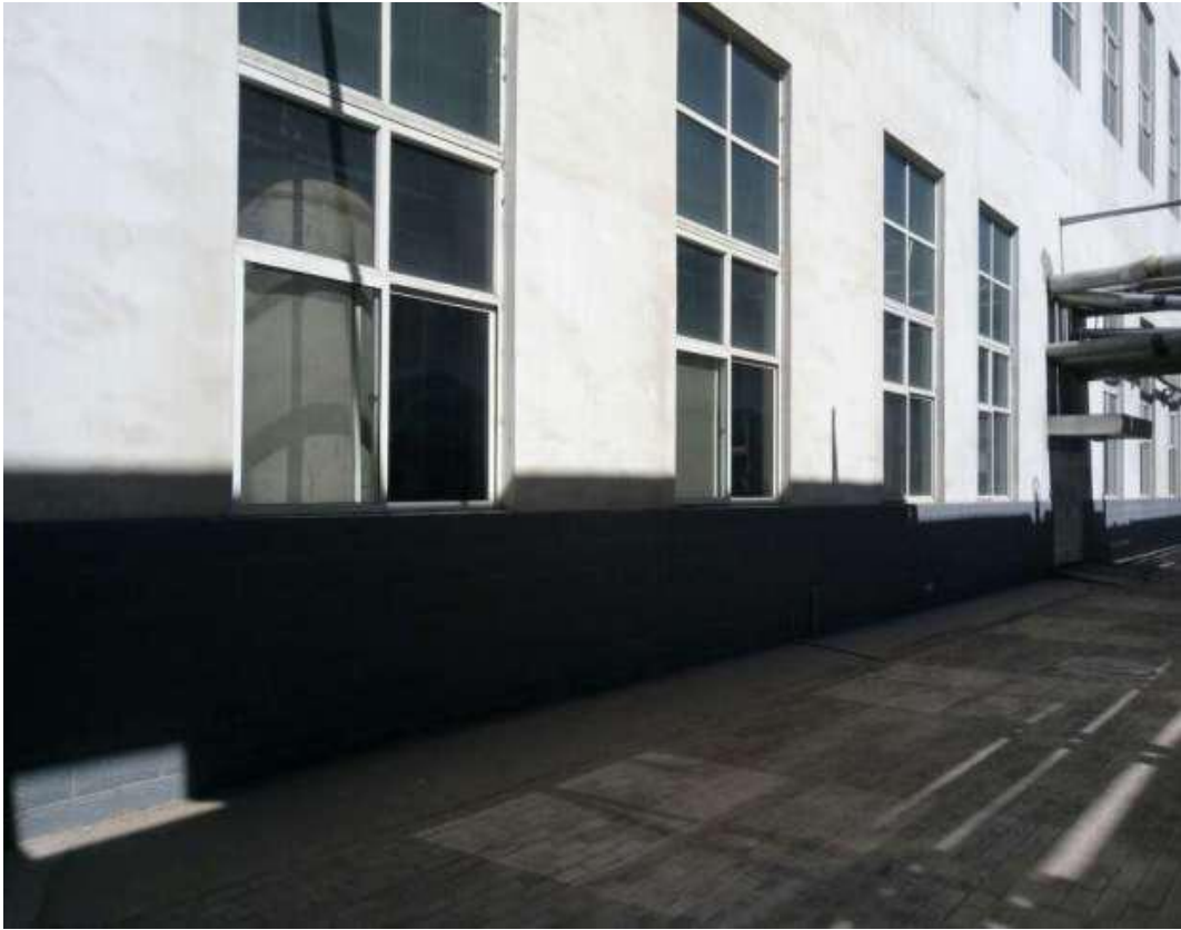
增压风机安装前
