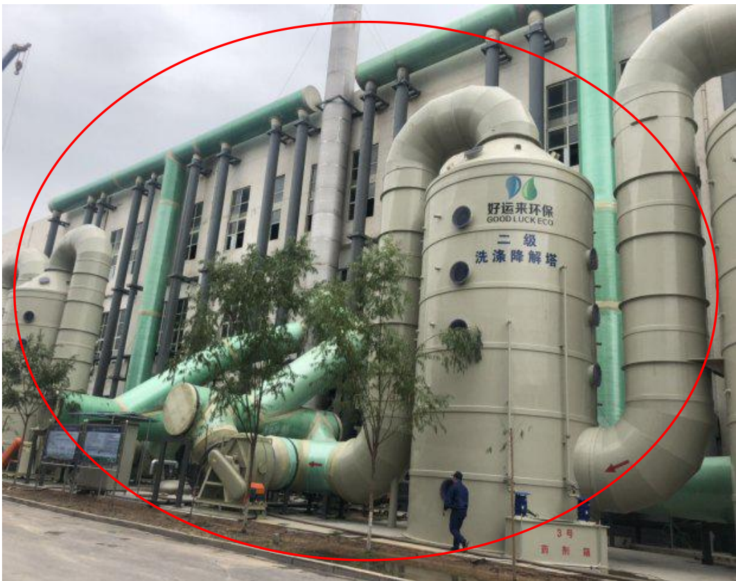
103 车间北侧整改后
