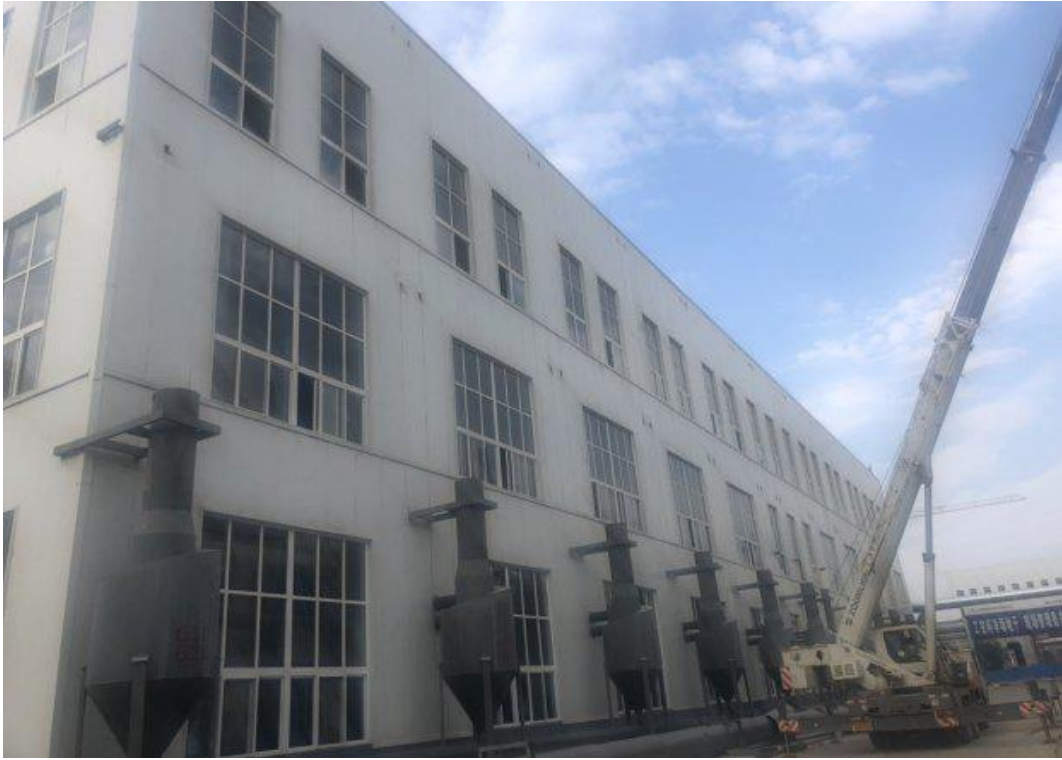
103 车间南侧整改前
