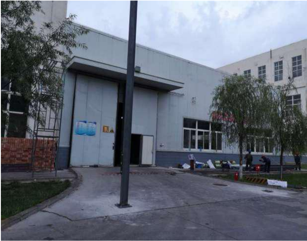
缓冲间建设前
