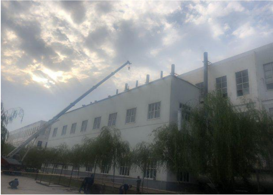
101 车间南侧整改前
