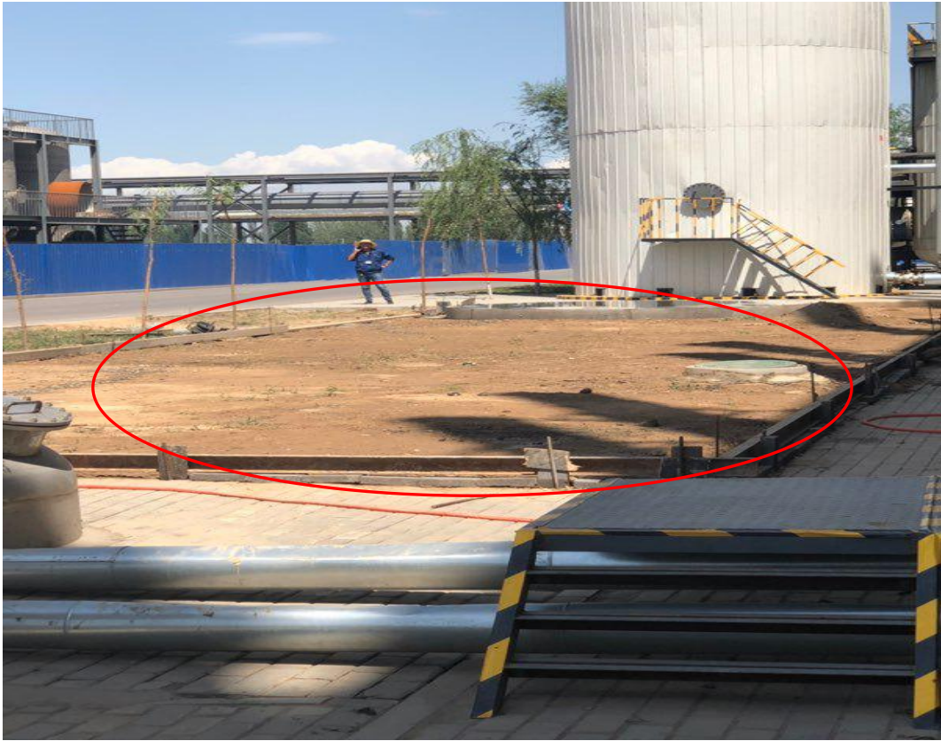
103 车间北侧整改前
