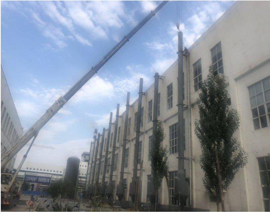
102 车间北侧整改前
