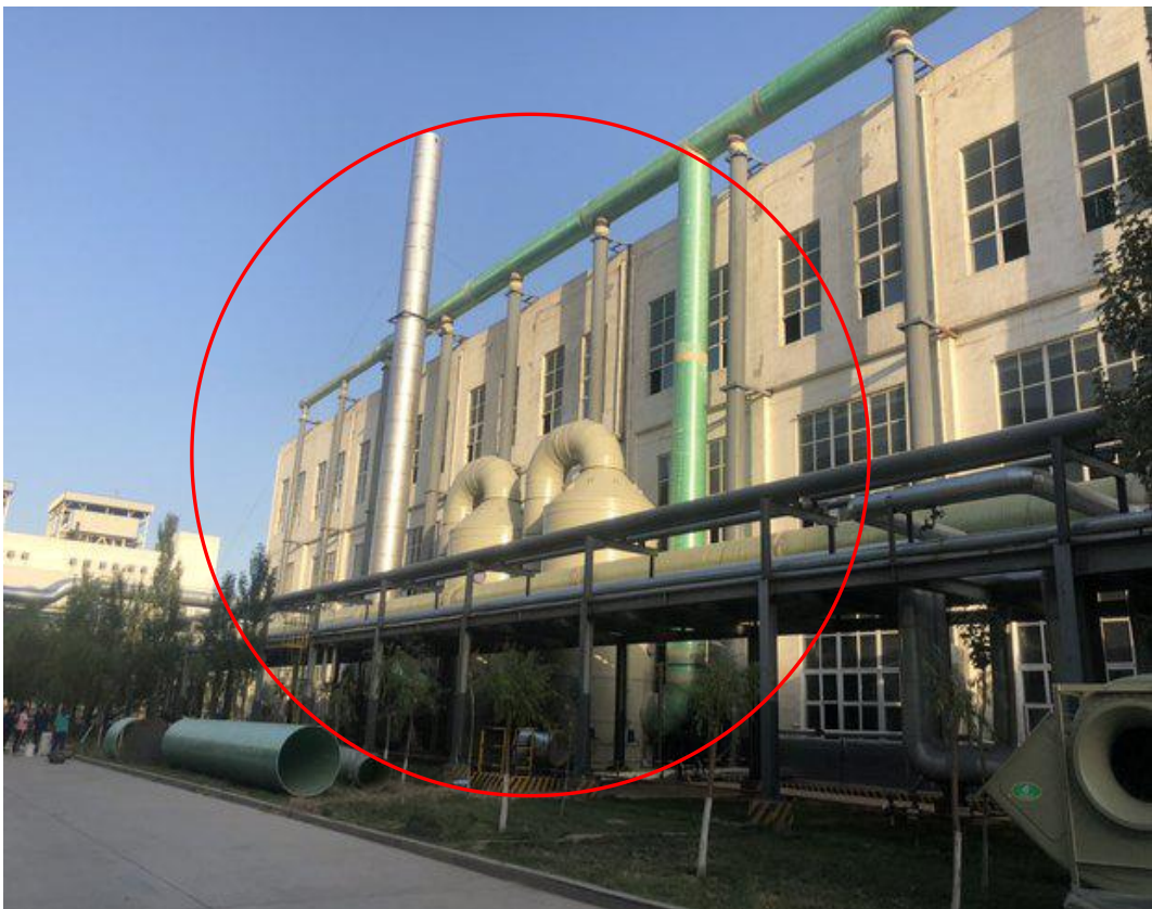
101 车间北侧整改后
