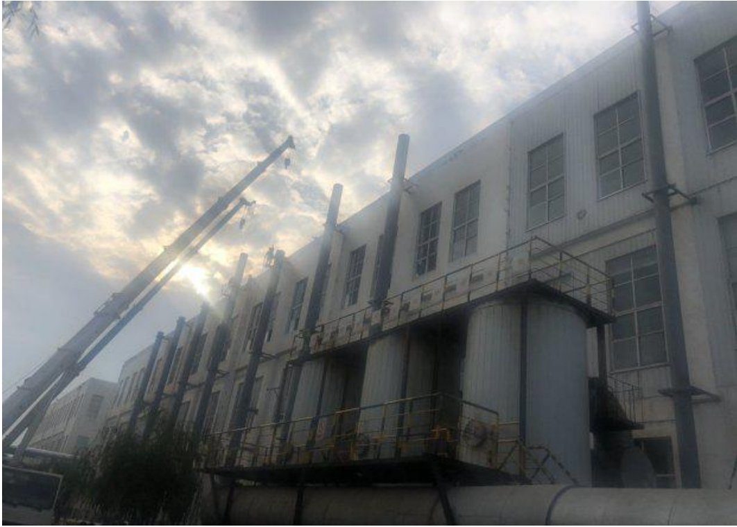
102 车间南侧整改前
