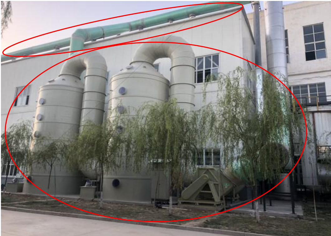
101 车间南侧整改后
